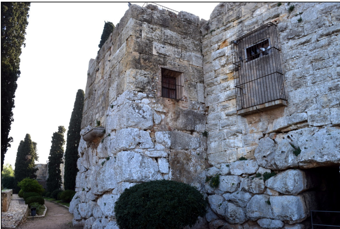
Fig.4 Vista de la torre del Cabíscol i una poterna de la muralla de Tarraco (Font: Elaboració pròpia)
