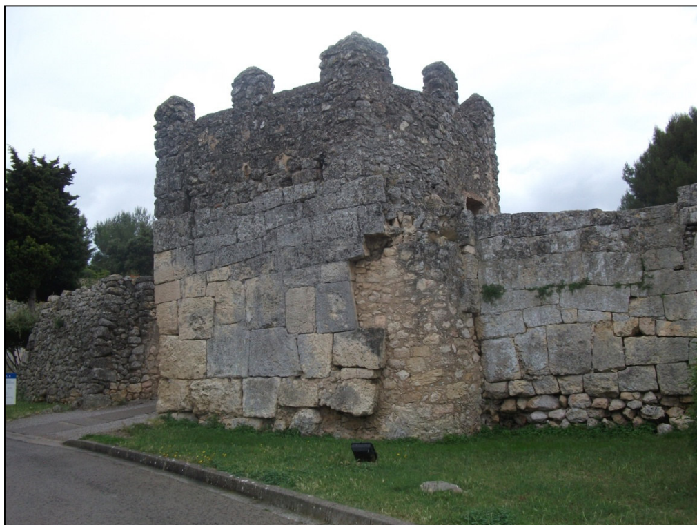
Fig.42 Muralla i torre 3 d'Olèrdola. Flanc dret de la porta (Alt Penedès) (Font: Elaboració pròpia).
