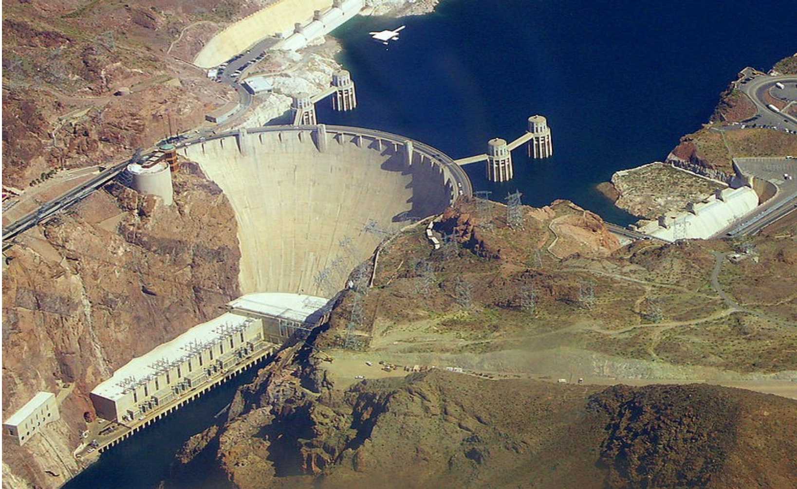
Ilustración 8: Presa Hoover del tipo mixto arco-gravedad
