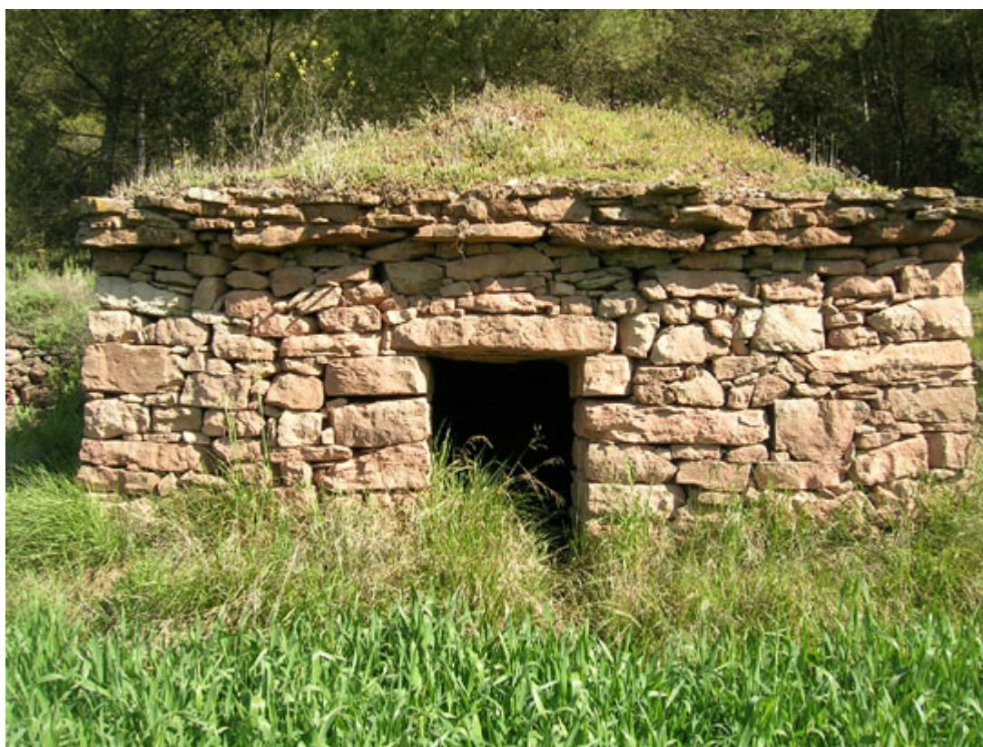
Barraca de vinya amb marcat voladís o escopidor (Santpedor)
