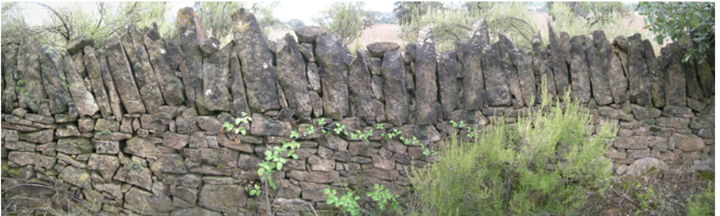
Acabament mur en rastell o "plec de llibre" (Fonollosa)
