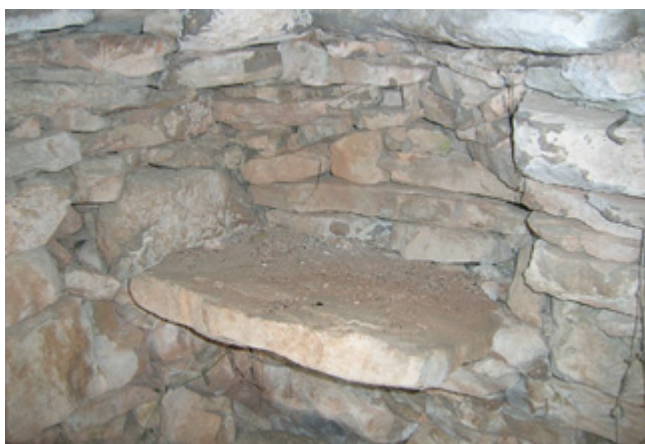
Banc o pedrís inserit a la paret interior de la barraca (Pont de Vilumara i Rocafort)
