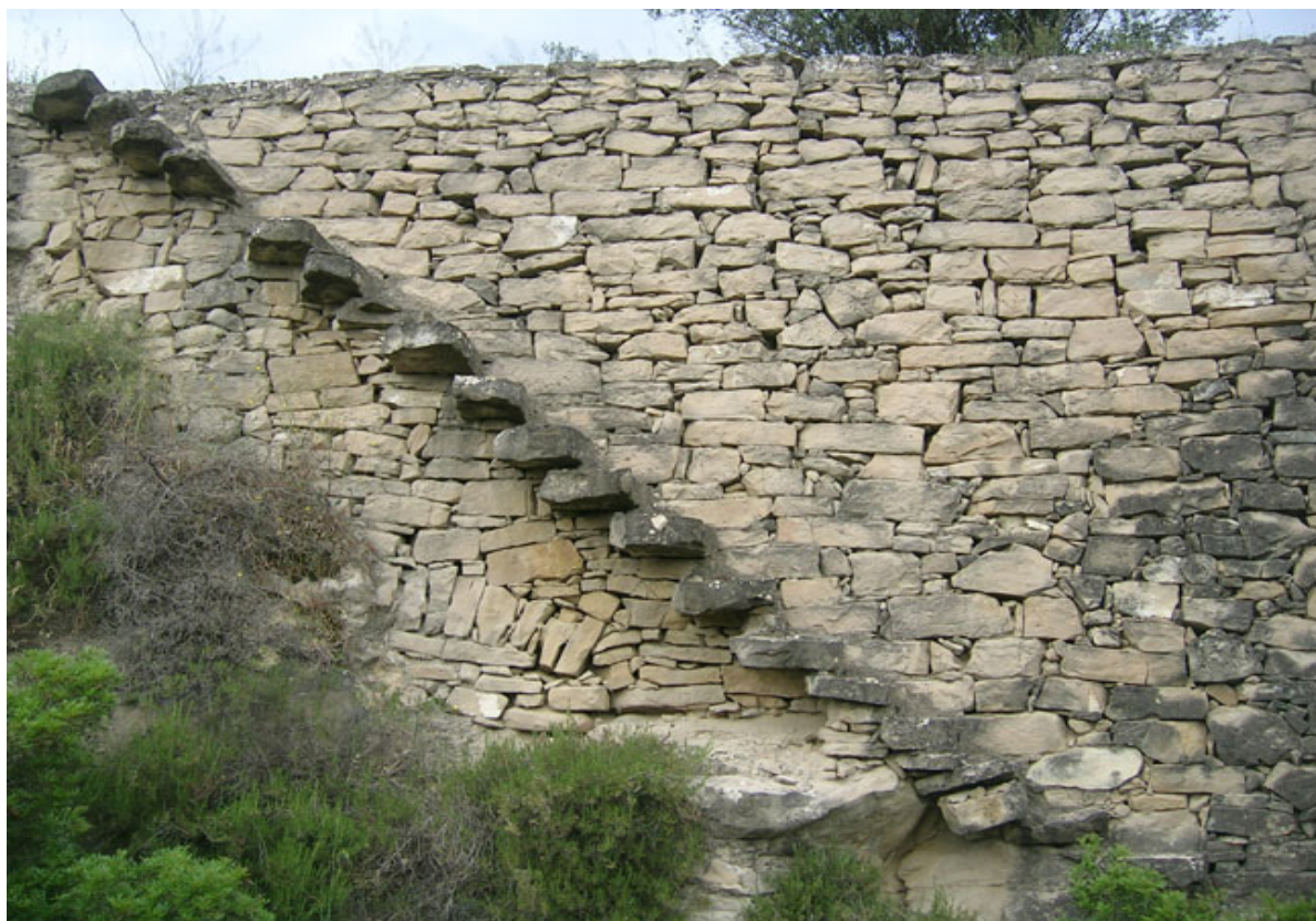
Marge de pedra seca amb escales inserides de més de 6 metres d'alçada (Manresa)
