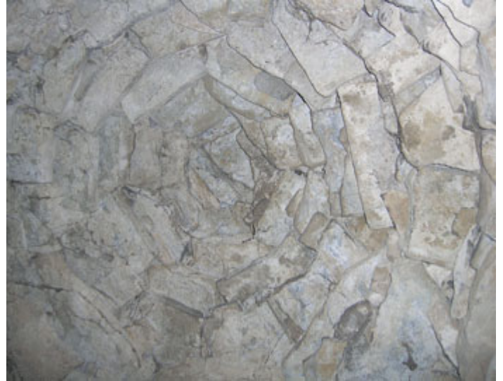
Sistema de cobriment en anells concèntrics
