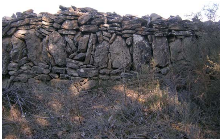
Marge amb pedres disposades en vertical i planes (Artés)
