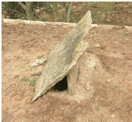
Claraboia o sortida de fums. Pedra quadrada inclinada (Sant Mateu de Bages)
