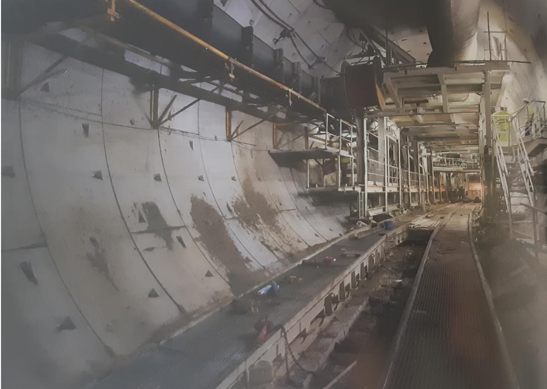
Ilustración 2. Ampliación de Línea 11 con tuneladora [13]
