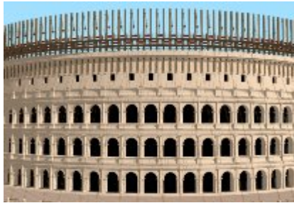
Vista del Coliseum amb el sistema de fixació dels parasols. (velums)
