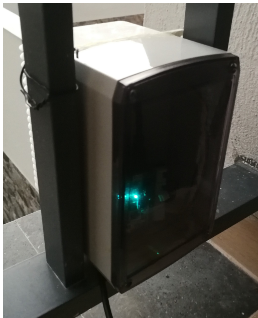
Figura 4.2: Fotografia anterior del dispositiu presa des del balcó.
