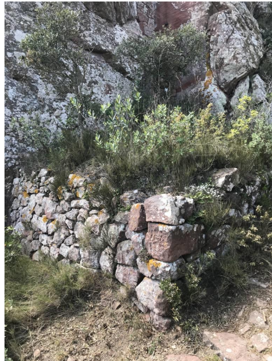
Imatge 38. Detall dels fonaments de la fortificació. Imatge digital de l'autor. 2021.
