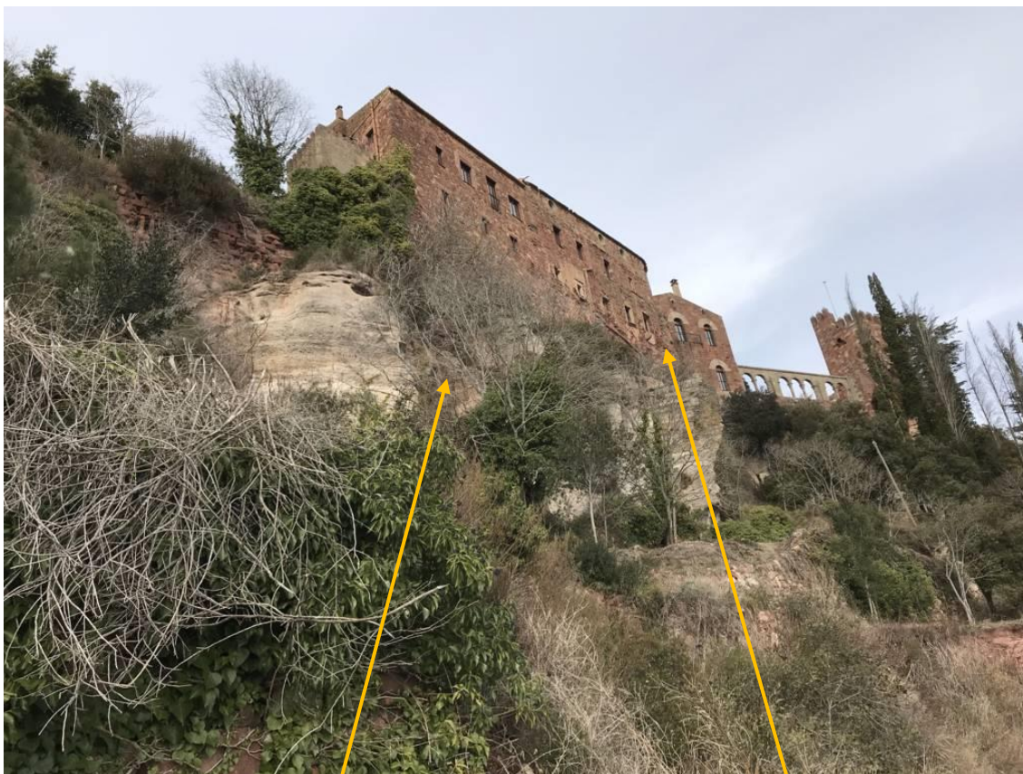
Imatge 10. Tram final de la muralla, reaprofitat per suportar el pes de la façana sud de l'actual casa senyorial. Fotografia de l'autor. 2017. La muralla continua de forma intermitent entre els arbres i arbustos, resseguint la línia de carena (575 m) que forma un espadat imponent.
