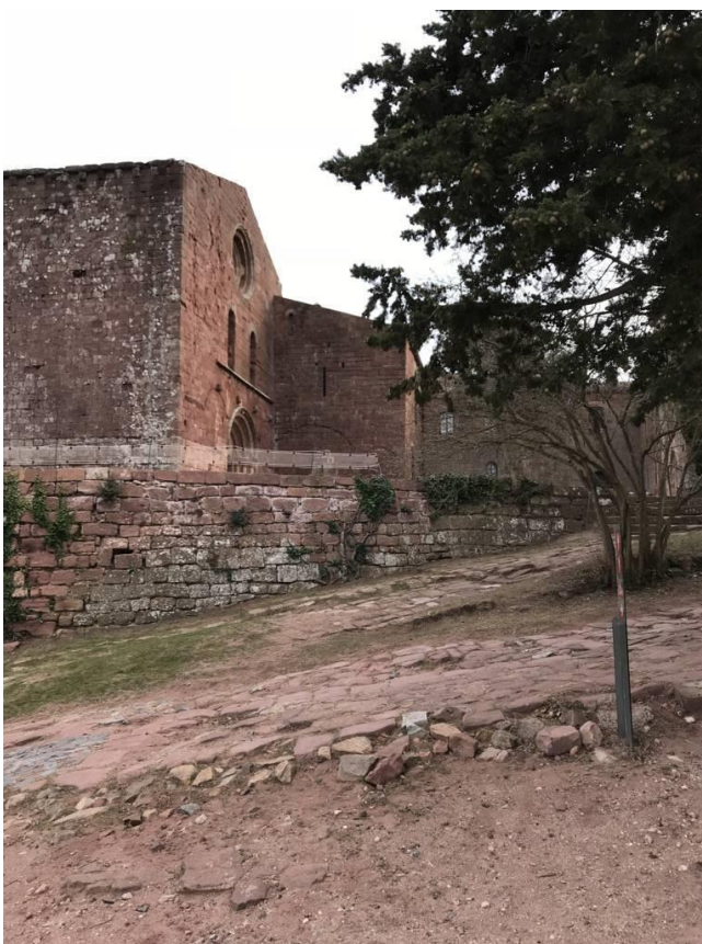
Imatge 18. Tram final del camí d'accés al conjunt monumental. Imatge digital de l'autor. 2021. Al fons l'església de Sant Miquel i la façana nord-oest de la biblioteca.
