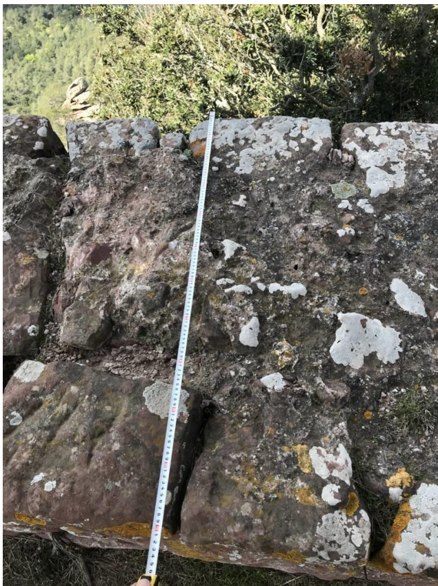
Imatge 42. Detall de l'amplada del mur de la torre del cim d'Escornalbou. Imatge digital de l'autor. 2021.
