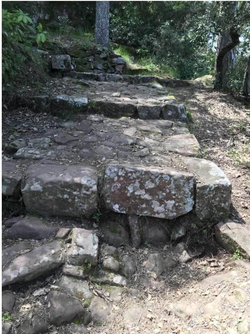
Imatge 36. Detall del camí empedrat que condueix al cim de l'ermita de Santa Bàrbara. Imatge digital de l'autor. 2021. És probable que aquests carreus formessin part de la muralla que comunicava el clos del cim amb el clos de l'actual pla de l'església.
