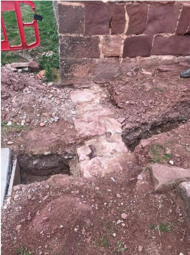
Imatge 26. Part d'una muralla soterrada. Vista frontal. Arranca al peu de la paret nord de l'església de Sant Miquel d'Escornalbou. Fotografia digital de l'autor. 2021. La direcció de la muralla és 246° SO, directe cap al punt més alt de la muntanya on ara es troba l'ermita de Santa Bàrbara.
