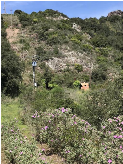
Imatge 50. Vessant nord-est de la muntanya d'Escornalbou. Al peu, a la dreta, construcció abandonada de la mina "Iris 18". Imatge digital de l'autor. 2021.
