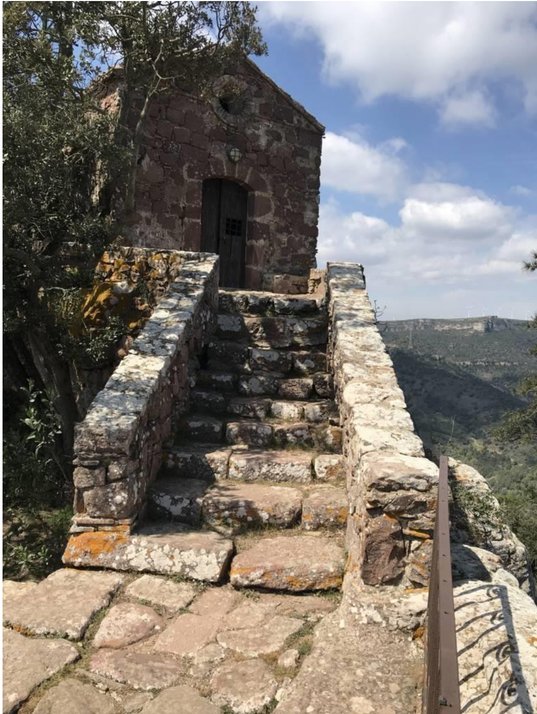
Imatge 43. Tram final del camí d'accés a l'ermita de Santa Bàrbara. Els carreus de color blan evidencien que formaven part de la muralla i de les dues torres del clos. Imatge digital de l'autor. 2021.
