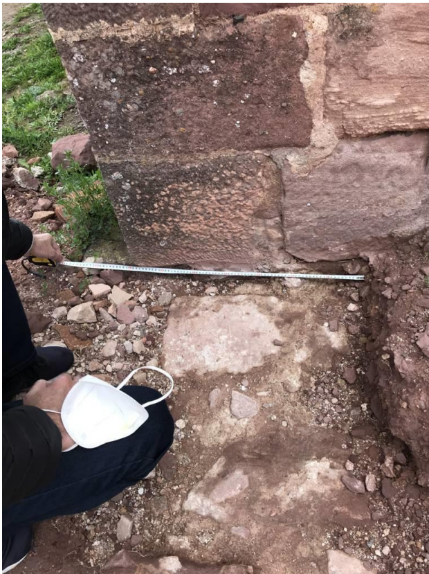
Imatge 29. Detall del peu de la façana de l'església de Sant Miquel. Potser, el mur soterrat s'esten fins a la cantonada de la paret nord. Imatge digital de l'autor. 2021.
