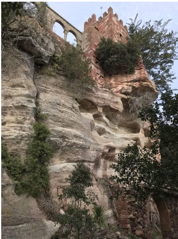
Imatge 14. Part de l'antiga muralla exterior reaprofitada per construir-hi al damunt el solament de la torre est i les arcades de l'antic claustre convertit en pati per Eduard Toda. Imatge digital de l'autor. 2017.
