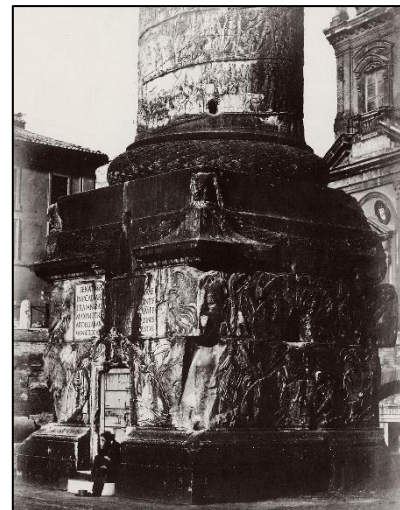
Figura 26. Pedestal de la columna de Trajano con la puerta de acceso a la cámara funeraria y la escalera interior. (Wikimedia Commons)
