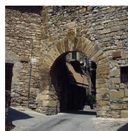
Figura 19. Portal de Tàrrega
