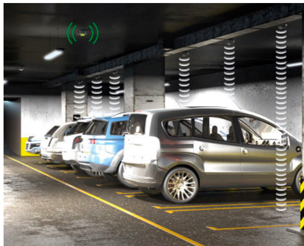
FIGURA 2 - SENSORES MAGNÉTICOS INSTALADOS EN EL TECHO DE UN PARKING SUBTERRÁNEO.
