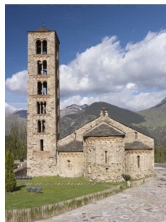
Exterior de l'església de Sant Climent de Taüll
