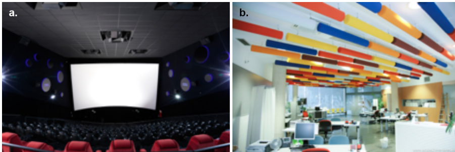
Figura 17. a) Instal·lació de panells porosos a un cel ras. b) Instal·lació de cilindres porosos suspesos del sostre
