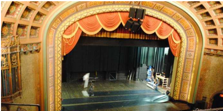
Figura 18. Exemple real de clúster central format per sis altaveus enfocats a l'audiència
