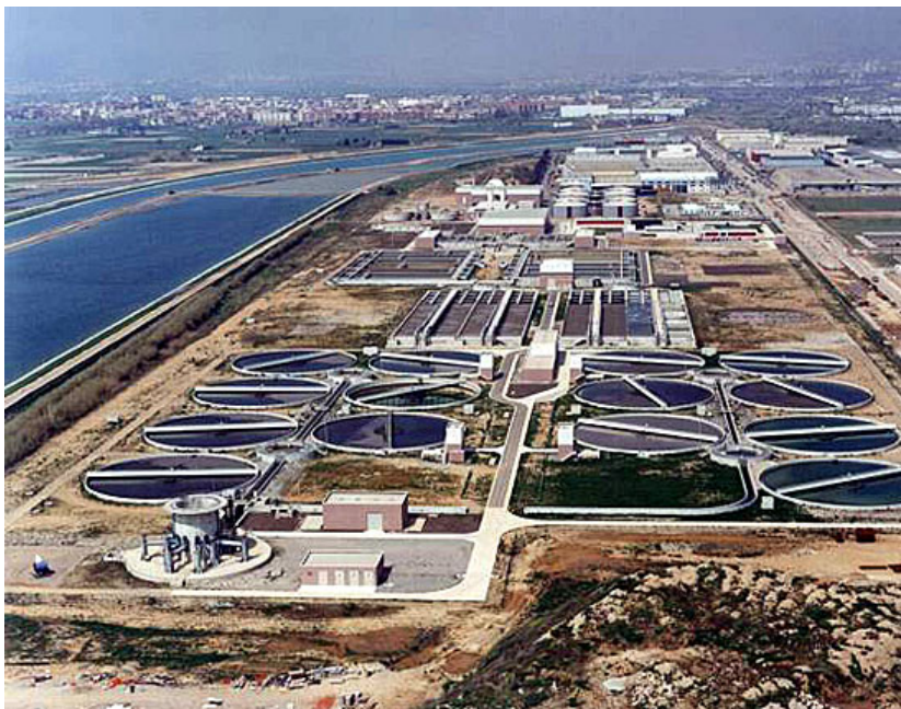
Planta depuradora del Llobregat: tratamiento biológico y tratamiento terciario
