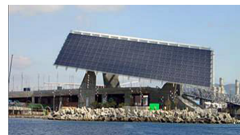
Planta solar fotovoltaica de 440 kW, instalada en el Forum 2004 de Barcelona
