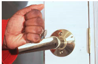
Figura 13. Una manivela en una puerta como ejemplo de diseño que exige poco esfuerzo físico
