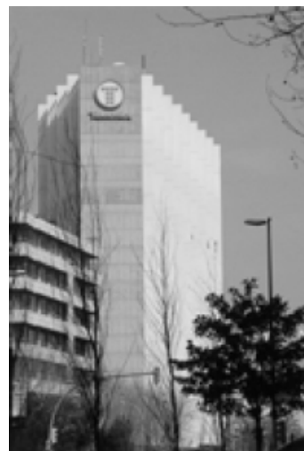
Edifici de Telefónica a Barcelona
