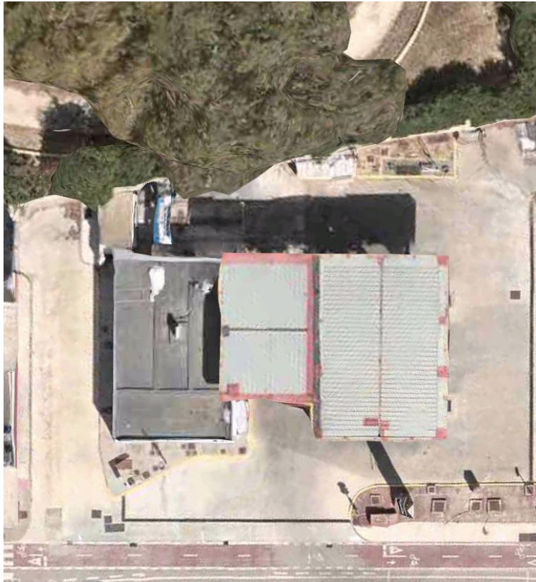
Figura 27. Vista aérea de la electrolinera
