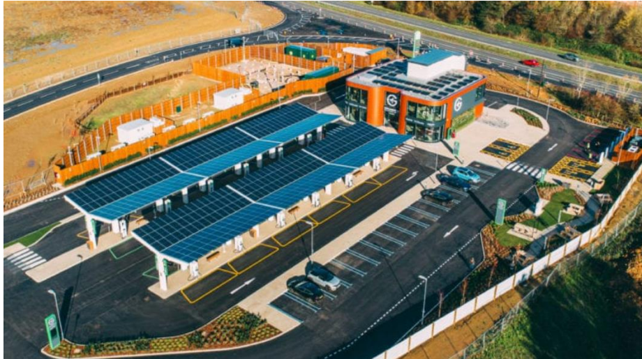
Figura 8. Estación de carga 'Electric Forecourt Gridserve' [20]
