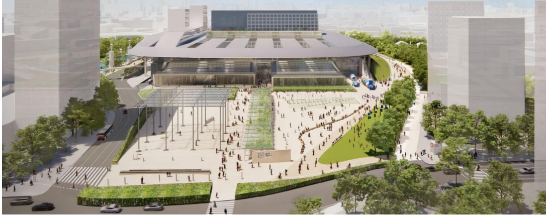
Gráfico 11. Renovación de Estación Sants, Barcelona. Extraído de: Arquitectura Viva
