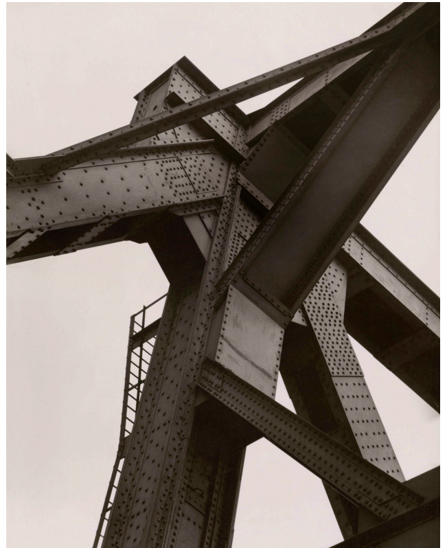
Renger-Patzsch. (1928). Ein Knotenpunkt der Fachwerkbrücke Duisburg-Hochfeld [Fotografía]
