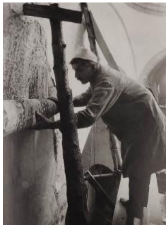
Fig. 4 – Cividini enrollando las pinturas a medida que las va desprendiendo del muro (Arxiu Mas, IAAH)
