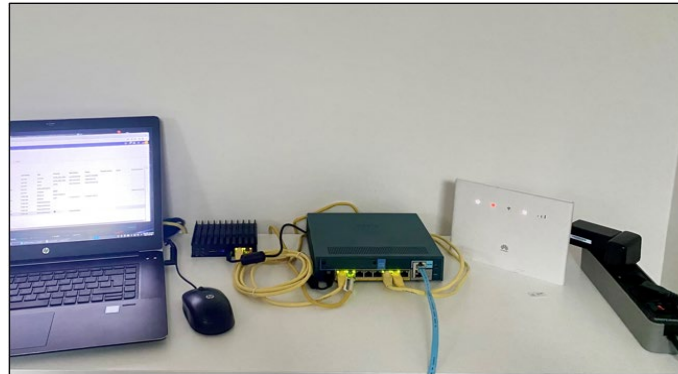
Ilustración 4: Laboratorio de pruebas Planta Industrial UOC en construcción
