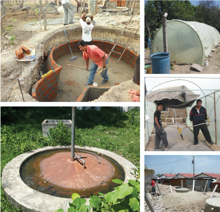
Figura 29. Construcción de un biodigestor en Haití
