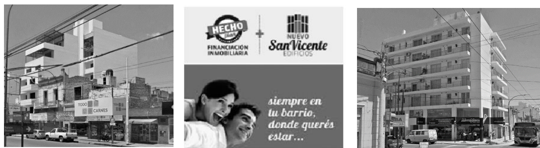
Figura 49. Imágenes renovación edilicia en altura TCB San Vicente
