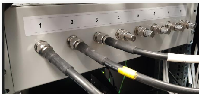
Figura 100 – Conexión del cliente (OBM) al atenuador
