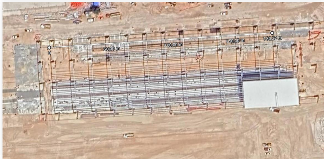
Figura 87 – Cobertura WiFi en Talleres y Cocheras (depósito de trenes)
