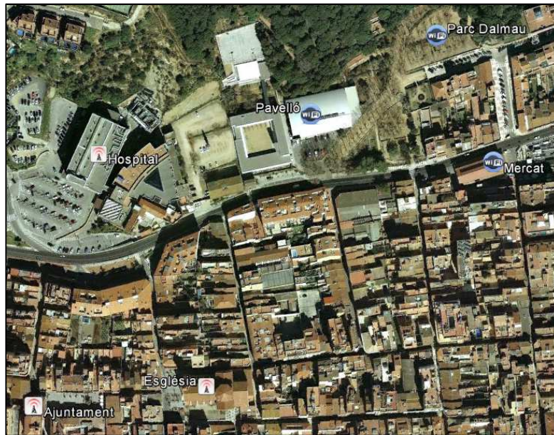
Il·lustració 23: Panoràmica Ajuntament - Hospital, Google Earth
