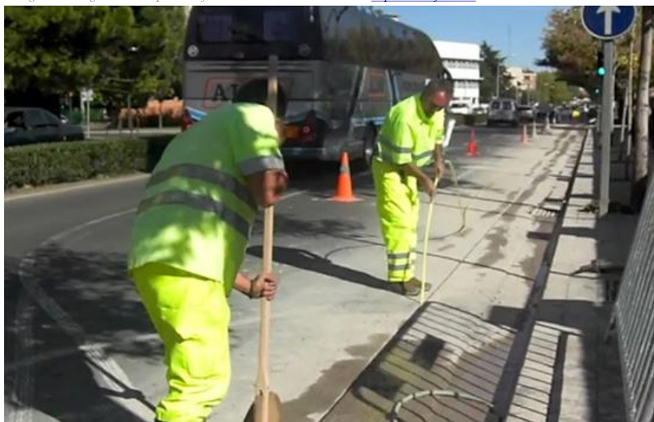
Imatge 22: Introducció del cable de fibra òptica. Font: http://www.smartel.es
