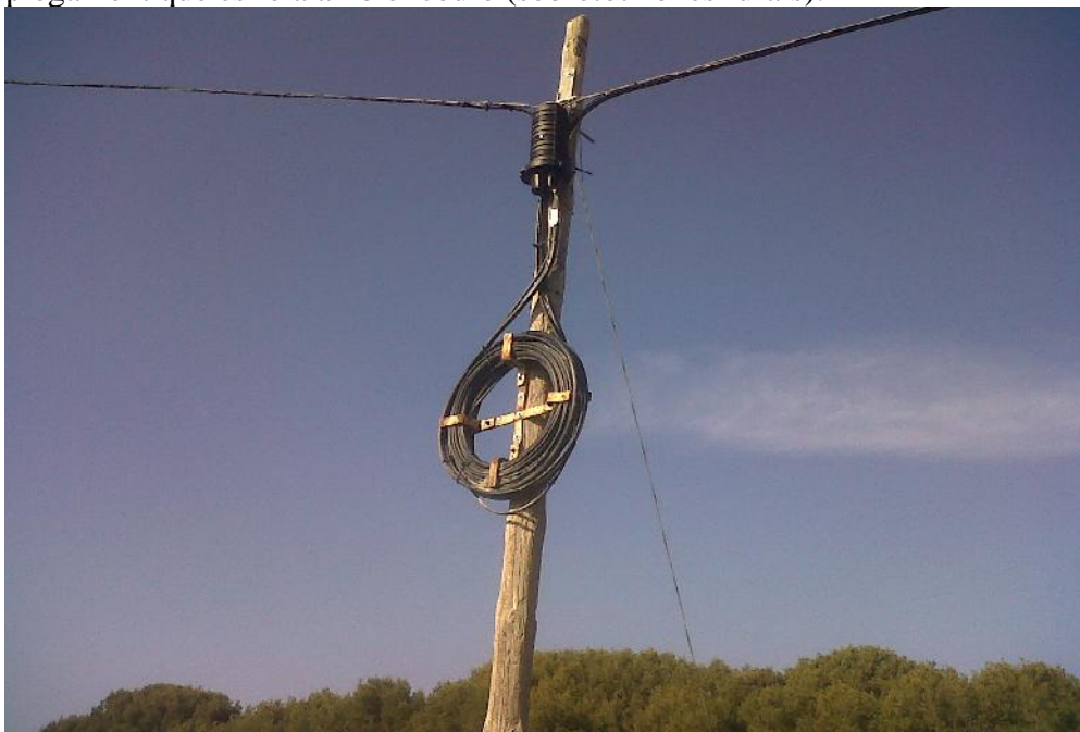
Imatge 25: Pal amb fibra aèria. Font: http://www.inframetel.com
