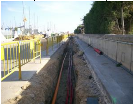
Imatge 19: Rasa oberta. Obra civil. Font: http://www.ocil.es/
