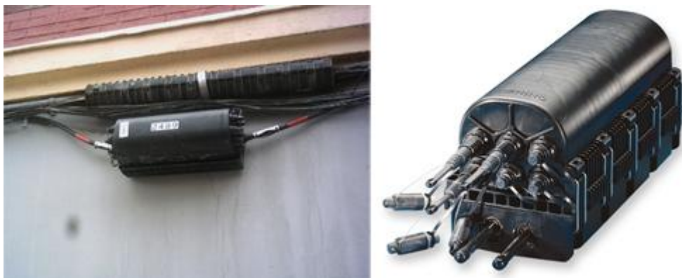
Imatge 15: CTO (torpedo) Corning. Font: http://cnmcblog.es/
