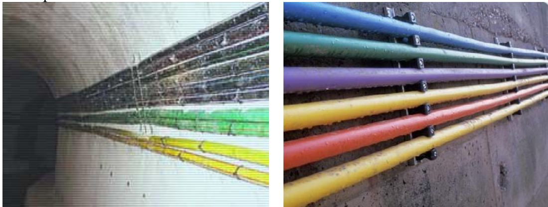
Imatges 23 i 24: Conductes de fibra òptica pel clavegueram. Font: http://www.clabsa.es i http://www.adif.es
