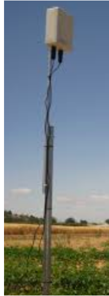
Figura 40 Instalación final nodo
