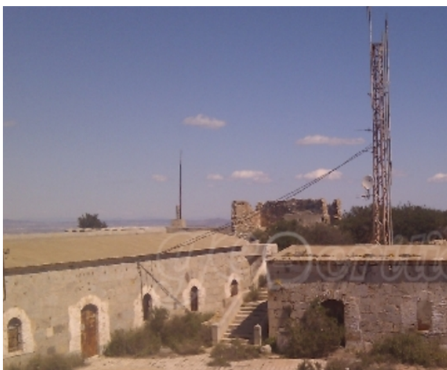
53. Ilustración: Ubicación física estación base en Monte San Julián
