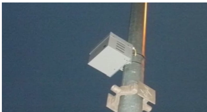
55. Ilustración: Soportación sobre poste de sección circular
