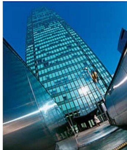
Ilustración 7: Edificio con gestión técnica automatizada http://www.arqhys.com/contenidos/inmótica.html
