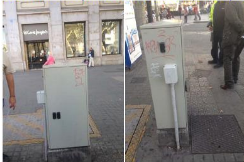
Quadre semafòric d'on es prendrà l'alimentació del nou WIFI provisional (detall)
