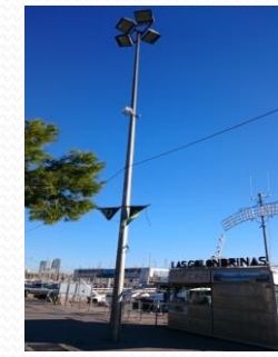
Imatges dels 5 AP's instal·lats en la zona del Moll de les Drassanes en els 5 fanals un en cada fanal, en aquest punt tenim AP's orientats cap a muntanya i AP's orientats cap a Mar per oferir cobertura en la zona del Moll.
