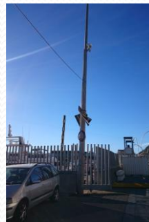
Imatges dels 5 AP's instal·lats en la zona del Moll de les Drassanes en els 5 fanals un en cada fanal, en aquest punt tenim AP's orientats cap a muntanya i AP's orientats cap a Mar per oferir cobertura en la zona del Moll.
