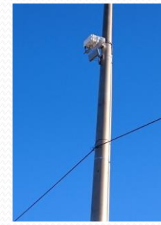
Imatges dels 5 AP's instal·lats en la zona del Moll de les Drassanes en els 5 fanals un en cada fanal, en aquest punt tenim AP's orientats cap a muntanya i AP's orientats cap a Mar per oferir cobertura en la zona del Moll.
