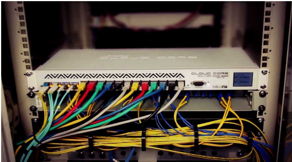
Fig. 20: Encaminador de altes prestacions una vegada instal·lat dins el rack.
