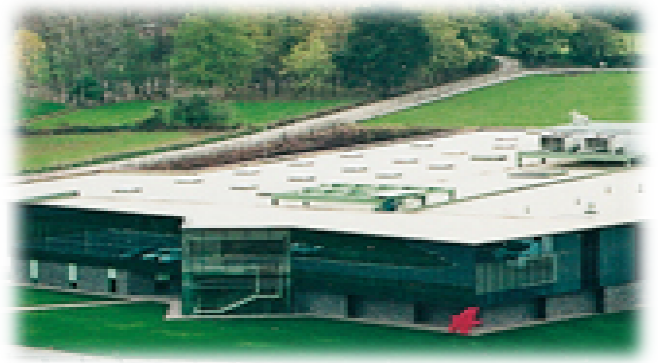
Fig.2: Vista de les instal·lacions
