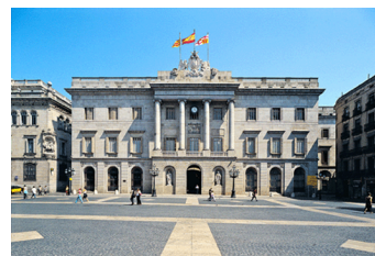
Façana de l'Ajuntament de Barcelona
