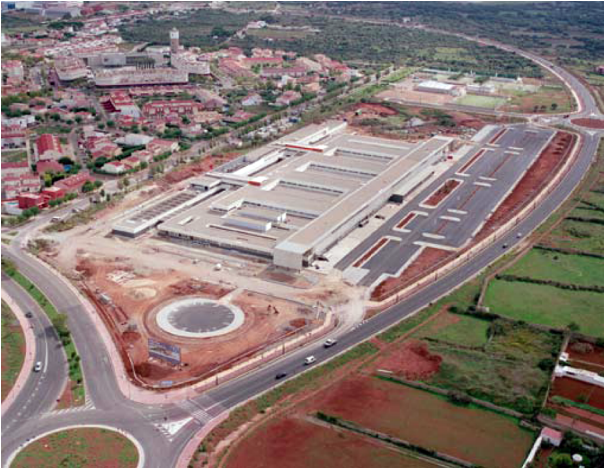
Ejemplos de hospital horizontal: Hospital Mateo Orfila, Mahón. Corea Morán Arquitectura
