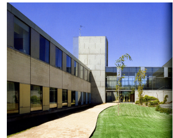
Hospital de Salt El edificio del Hospital de Salt se sitúa en un gran parque sanitario. La voluntad es que el parque fluya hasta el mismo edificio. (Arquitectos: M. Brullet y A. de Pineda)
