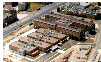
Instalaciones del Hospital de Igualada En cubierta, toda la climatización: producción de agua fría, caliente y climatizadores. En sótano: agua, gas y electricidad. (Arquitecto: E. Donato)
