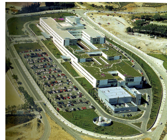
Instalaciones del Hospital de Mataró Edificio de instalaciones con todas las centrales que se comunica con una gran galería técnica con el corazón del edificio hospitalario. Sólo hay en el edificio principal climatizadores de zonas. (Arquitecto: Francesc Montaner, Generalitat de Catalunya)
