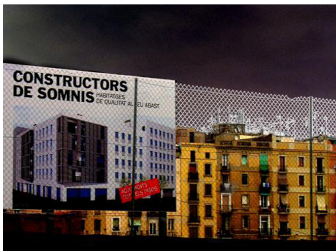
Construcció d'habitatges a la Rambla del Raval. Autor: Óscar López
