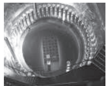
Lluentor blava produïda per la radiació Txerenkov al reactor de la central nuclear de Gösigen, a Suïssa
