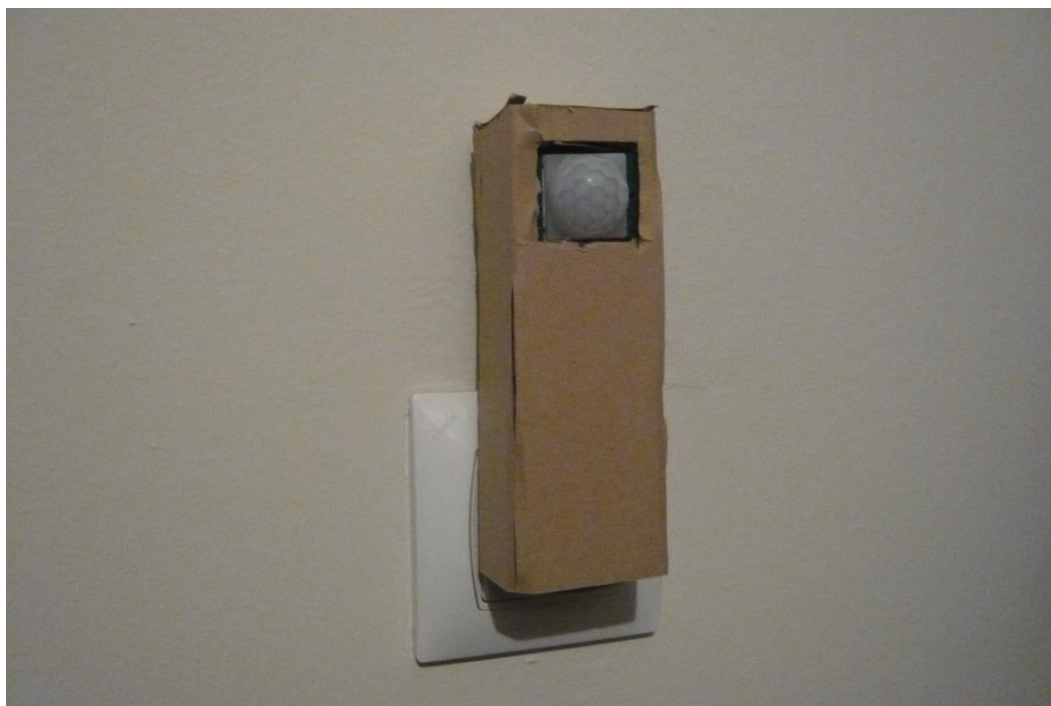
Il·lustració 31. Instal·lat al lloc.
