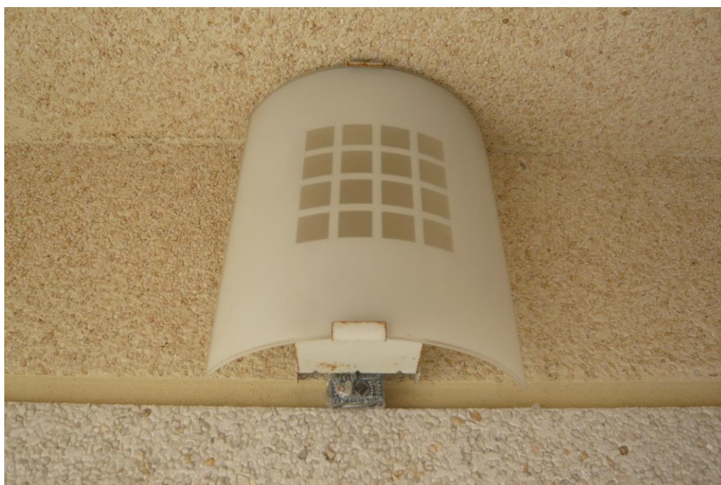
Il·lustració 36. Instal·lat al lloc.
