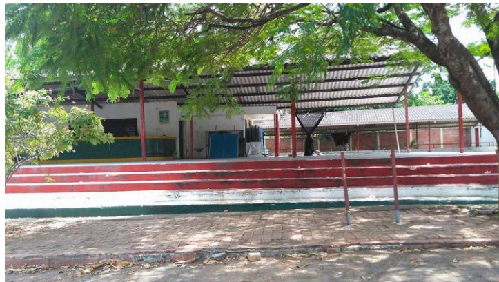
Espacio de entretenimiento sala de ferias José Alonso Escadón – Archivo personal
