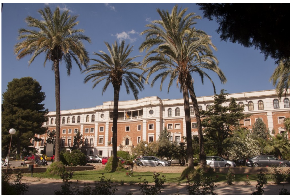
Figura 1: Edifici del CEEDCV en C/ Casa de la Misericòrdia
