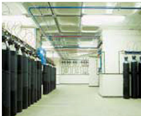
Imagen de batería de botellas de gases medicinales
