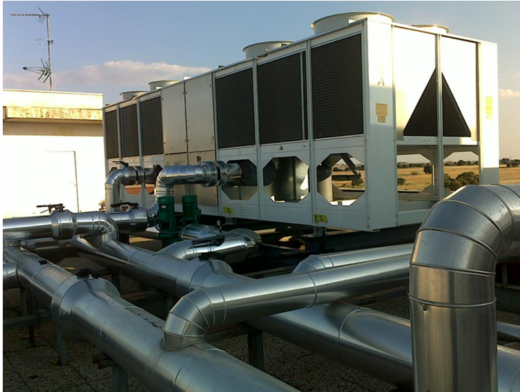
Bomba de calor
