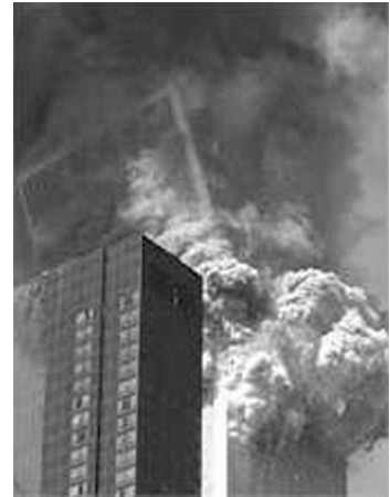
Esfondrament d'una de les Torres Bessones.
