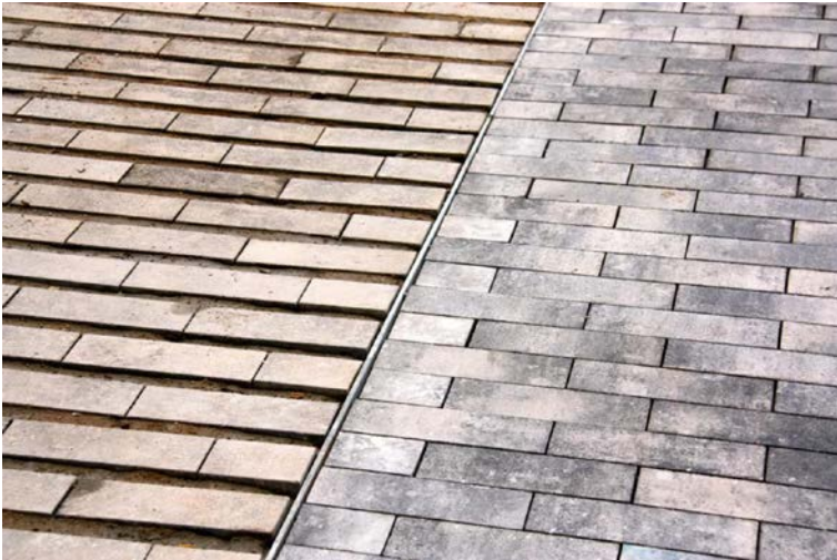
Figura 7. Imagen del pavimento utilizado en las áreas verdes y en las esquinas, con detalle de la junta en acero
