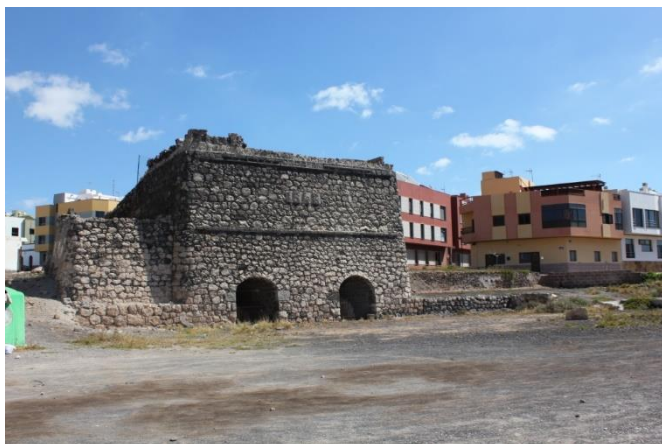
Fotografia del Forn de Çalç del Charco a Puerto del Rosario (Fuerteventura)
