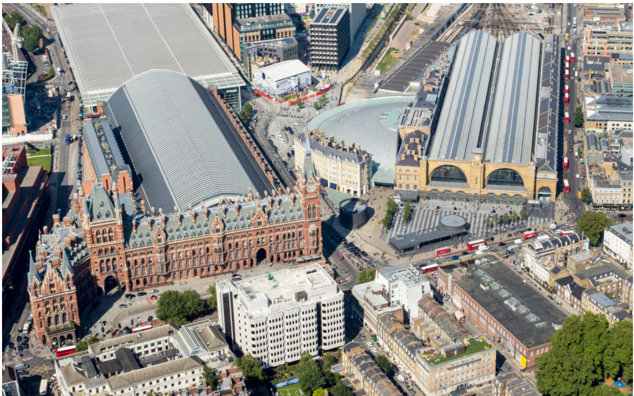
Figura 5.9. Estaciones de King's Cross y St Pancras. Fuente: Plowman Craven.
