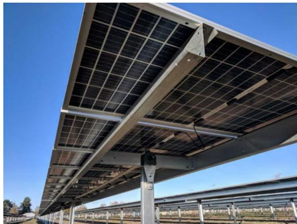
Fig. 7.17. Módulos bifaciales en sistemas de seguimiento solar [98]
