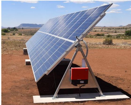
Fig. 9.2. Seguidor solar en un eje horizontal [105]
