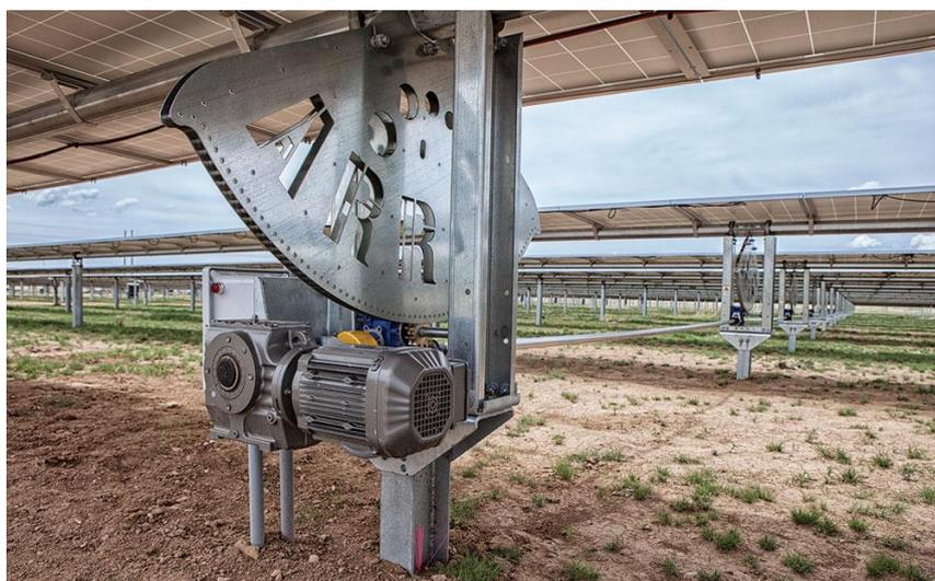
Fig. 9.12. Seguidor solar activo [108]
