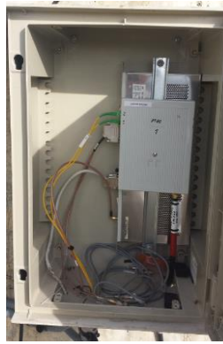
Il·lustració 33: Instal·lació PTRO
