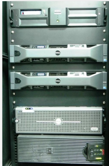
Imatge 3 – Imatge armari rack
