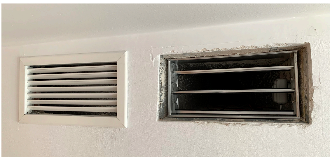
Imagen 16: Rejilla de retorno (Izquierda). Compuerta motorizada (Derecha)
